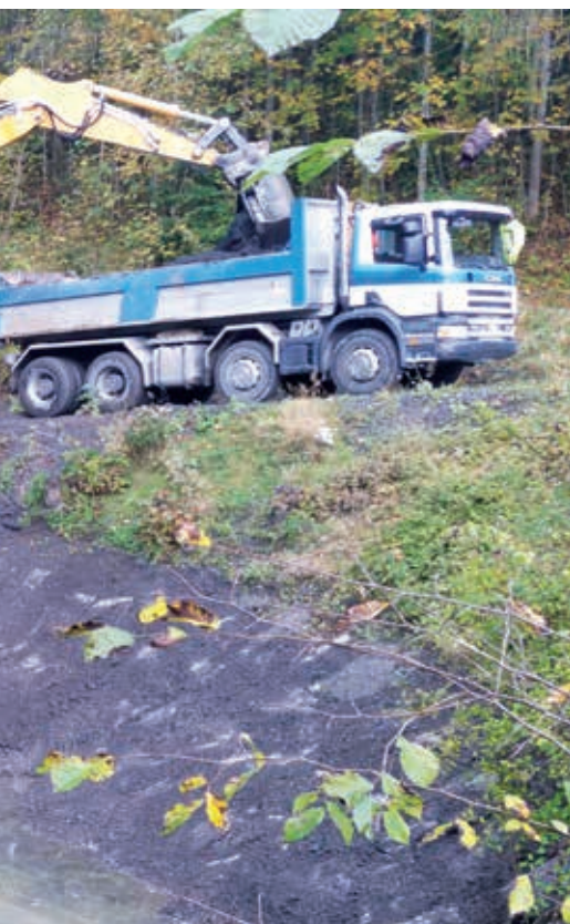
OLTSCHIBACH Jährliches Ausbaggern des oberen Oltschibachsammlers.
