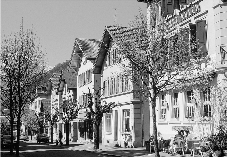
Blick in die Kreuzgasse (Nordseite). Die Aufreihung von schlichten giebelständigen Satteldachhäusern ist typisch für das innere Ortsbild. Am rechten Bildrand ist das Hotel Adler zu erkennen.
