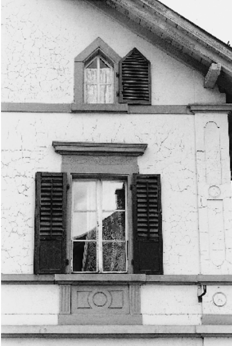
Kirchgasse 13, erbaut von Architekt E. Merz-Michel.
