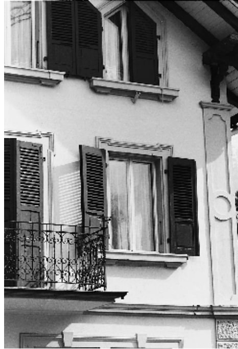
Kirchgasse 24, erbaut von Baumeister Jean Bissantz.
