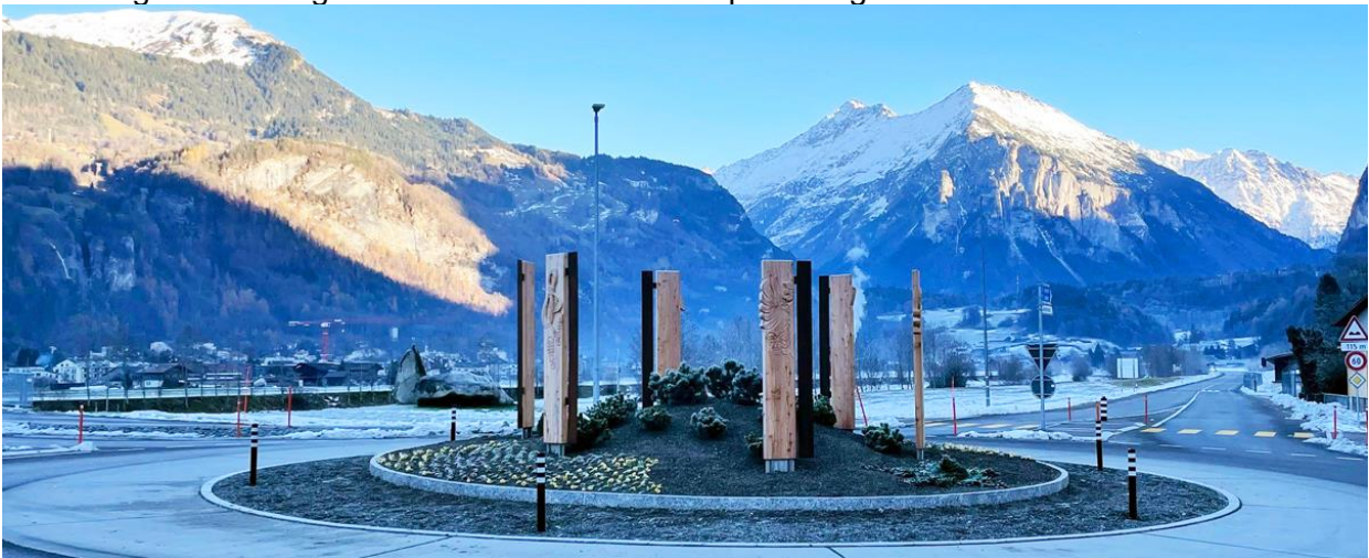
Sanierung/Erneuerung Kreisel Balm mit einem Verpflichtungskredit von CHF 70'000.00
